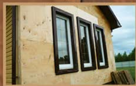
ВНУТРЕННЯЯ И ВНЕШНЯЯ ОТДЕЛКА
